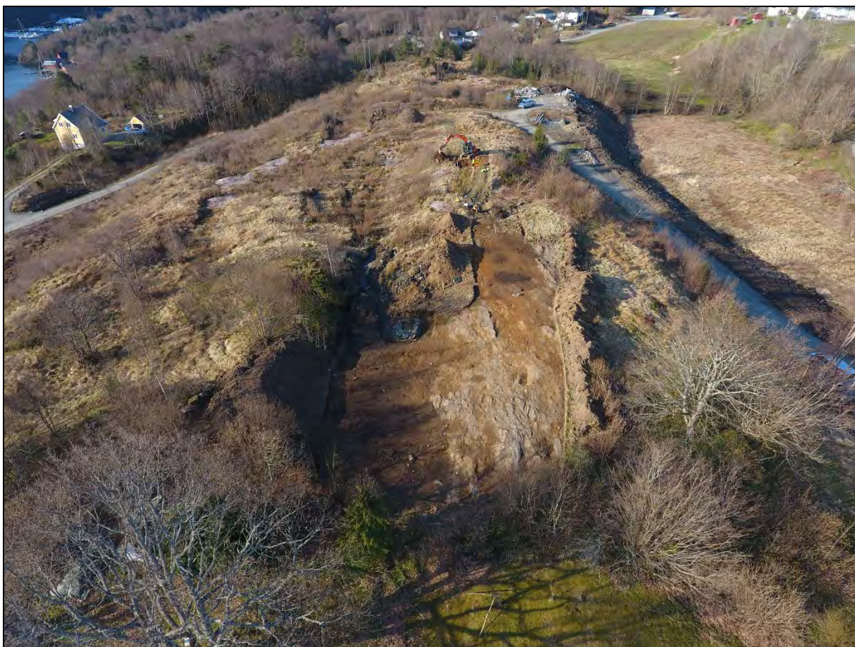
Figur 7. Dronefoto av Lok 1 etter avtorving. Gravemaskin synlig i bakgrunnen har begynt arbeidet ved Lok 2. Sett mot sørvest. Foto ved Universitetsmuseet i Bergen.
